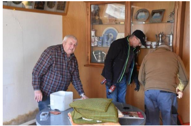
Jost beginnt bereits die Wand zu reparieren.
